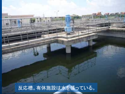
反応槽。エアレーション前状態。
