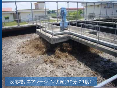
反応槽。エアレーション状況(30分に1度)
