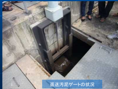
返送汚泥ゲートの状況
