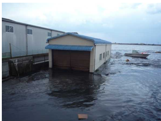
(津波により浸水した艇庫・ドック)
