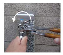
②蛇口を手でしっかりとささえ、ス ③蛇口の上部を取りはずします。 パナ等で上部を左 ✓ に回して ゆるめ、ハンドルを全開にします。
