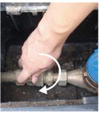
①止水栓を右へ に回して水を止めます。
